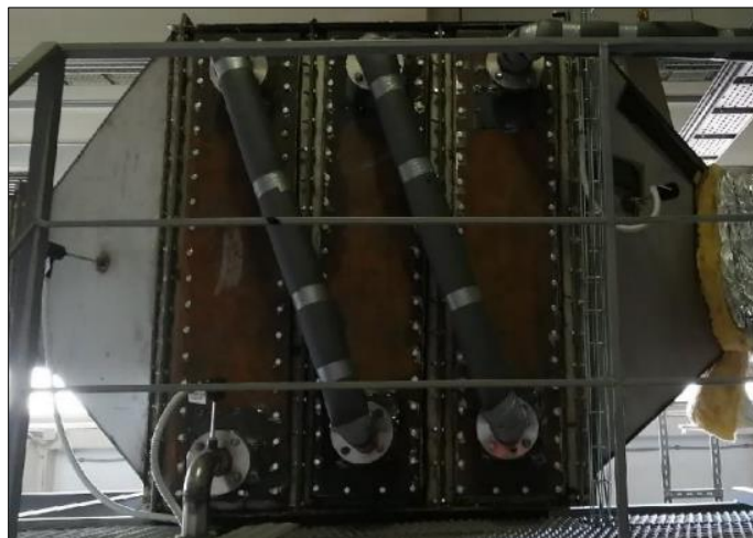
Рис. 1. Рекуперативный теплообменный аппарат на промышленном предприятии
